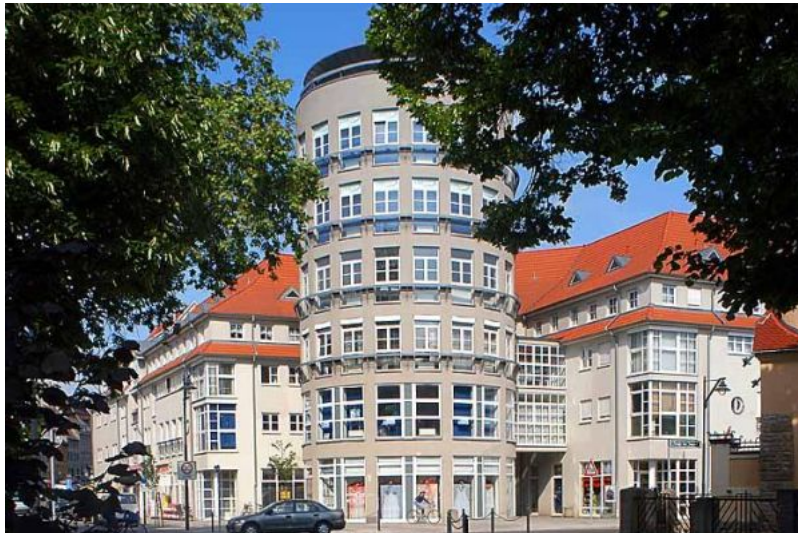
Firmenzentrale der CNS24 AG in der Stadt Torgau / Nähe Leipzig
