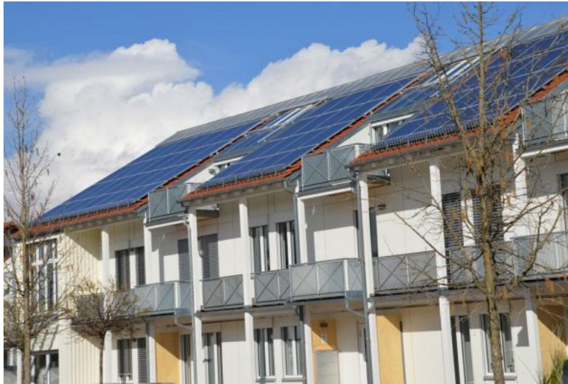
Doppel-Kraftwerke auf dem Dach: Solarthermie und Photovoltaik.
