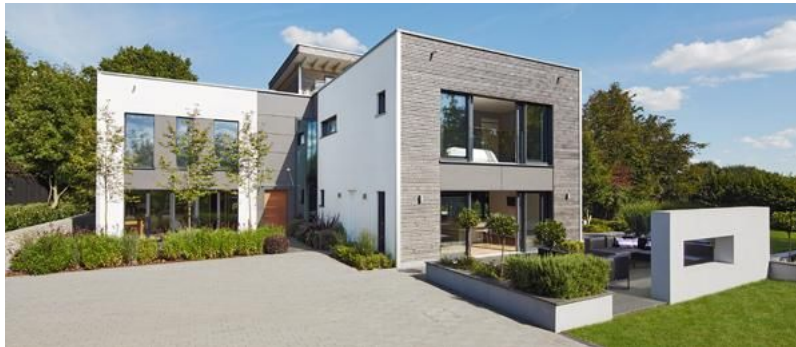
Weald House: Ein Haus - viele Gesichter
