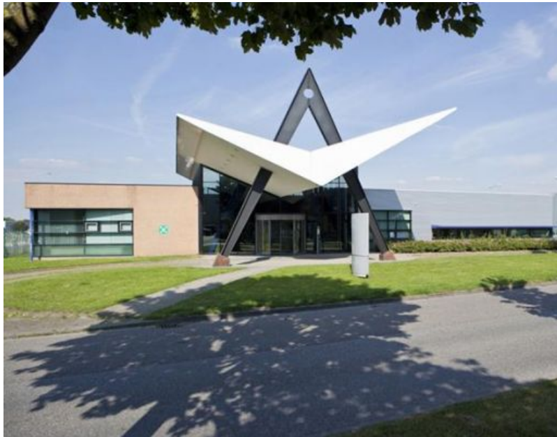
Der neue Standort des Unternehmens Haaß Sanitär-Heizung
