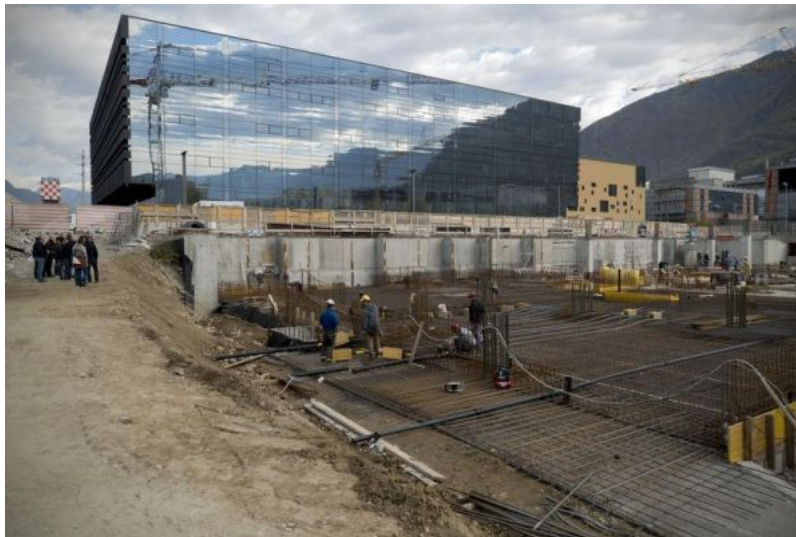
Baustelle (Eurac Research)
