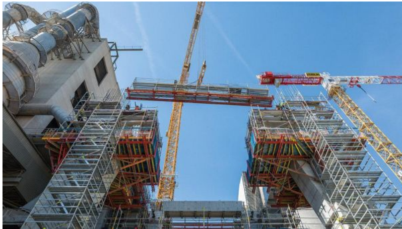
Die PERI Schalungs- und Gerüstlösung für die Rohbauarbeiten des neuen Wärmetauscherofens.
