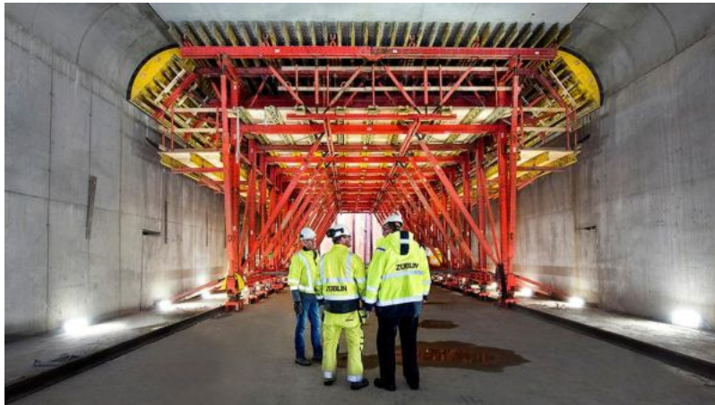
Deckenschalwagen sind modular. VARIOKIT Standardbauteile ermöglichen projektspezifische Anpassungen
