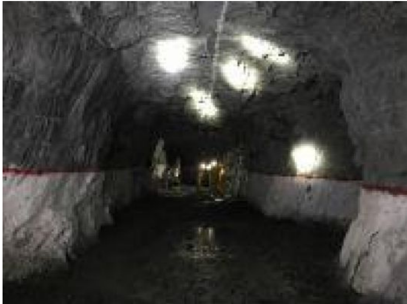
Neue Stollen auf der Blanket Mine
