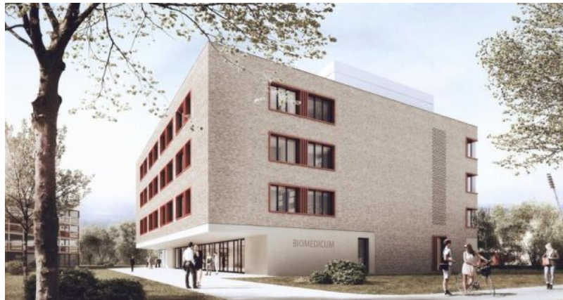
BIOMEDICUM – Forschungs- und Lehrgebäude der Universitätsmedizin Rostock, Baubeginn 2018 ()
