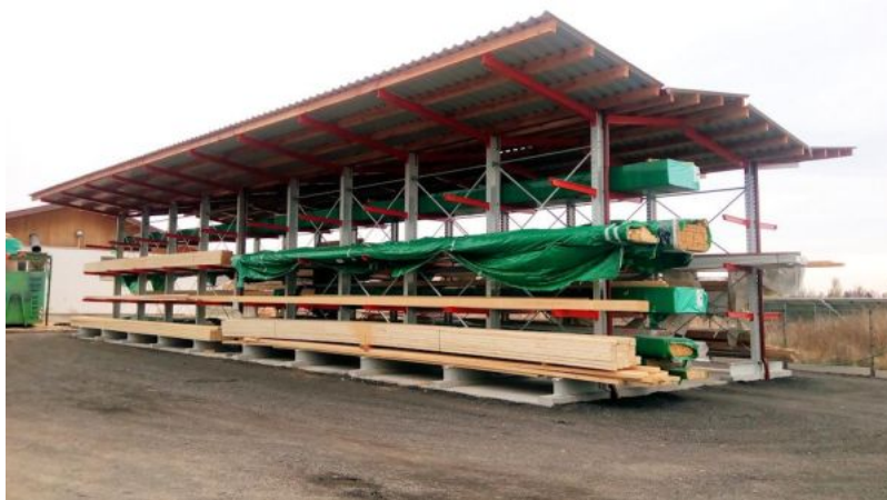
Die Ständer des OHRA-Regals dienen gleichzeitig als tragende Konstruktion für ein Dach. (Foto: NEMA)
