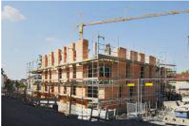
Das Mehrgenerationenhaus in Leonberg überzeugt mit energetisch hochwertigem Ziegel-Mauerwerk. (Bild: Unipor, München)
