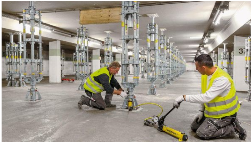
Die Montage, Demontage, hydraulisches Vorspannen und Absenken der Absenkspindel HD (Foto: PERI GmbH)
