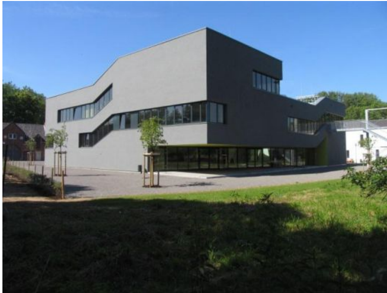
Das Science College im Bildungszentrum Overbach ist ein Projekt im Forschungsvorhaben »EnEff:Schule«
