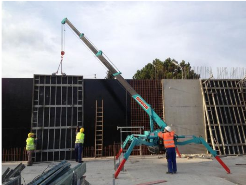
Die 700 kg schweren und 4,00 m hohen Schalungselemente waren für den Maeda MC 285 kein Problem.
