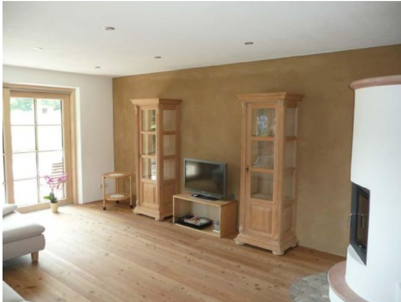
Lehmputze regulieren Wärme und Feuchtigkeit der Raumluft.
