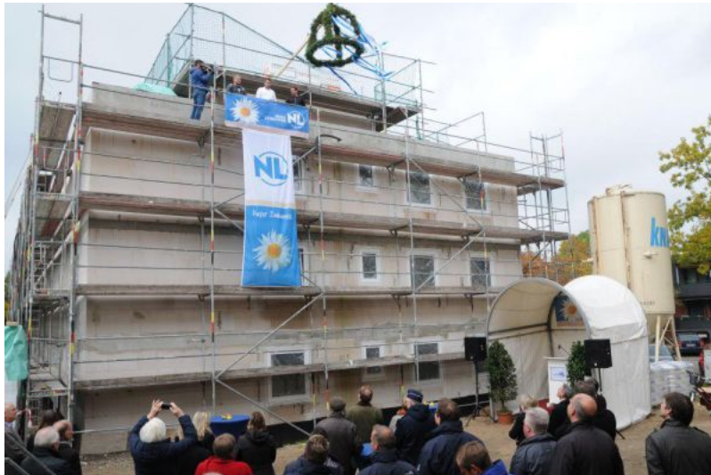
Das Richtfest bildet den offiziellen Abschluss der Rohbauarbeiten.
