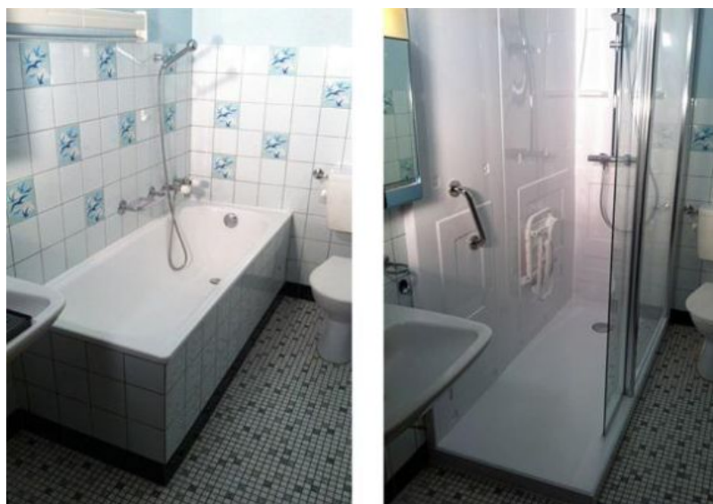
Badewanne entfernt - niedrige Dusche eingebaut
