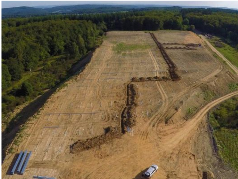
Der Solarpark in Mittenaar-Bellersdorf im Bau: nur 30% der Fläche werden von Modulen bedeckt sein.
