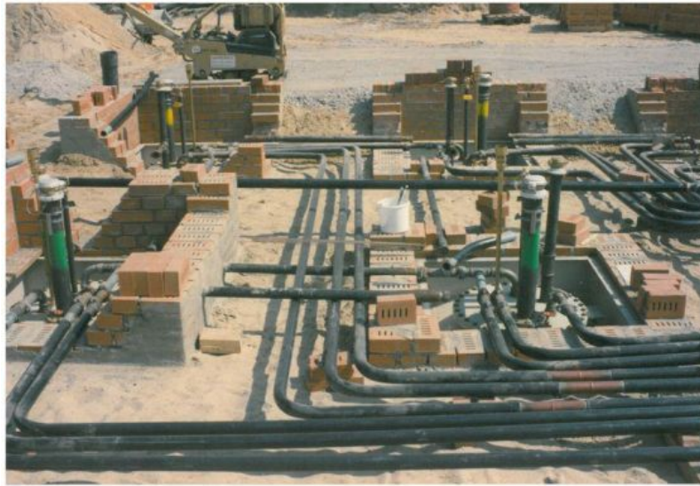
Foto: Gütegemeinschaft Tankschutz und Tanktechnik
