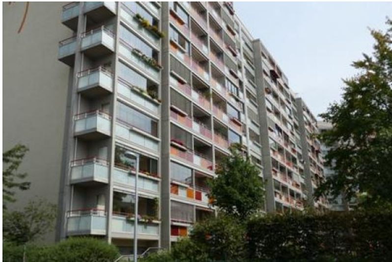
Balkonbau in Dresden
