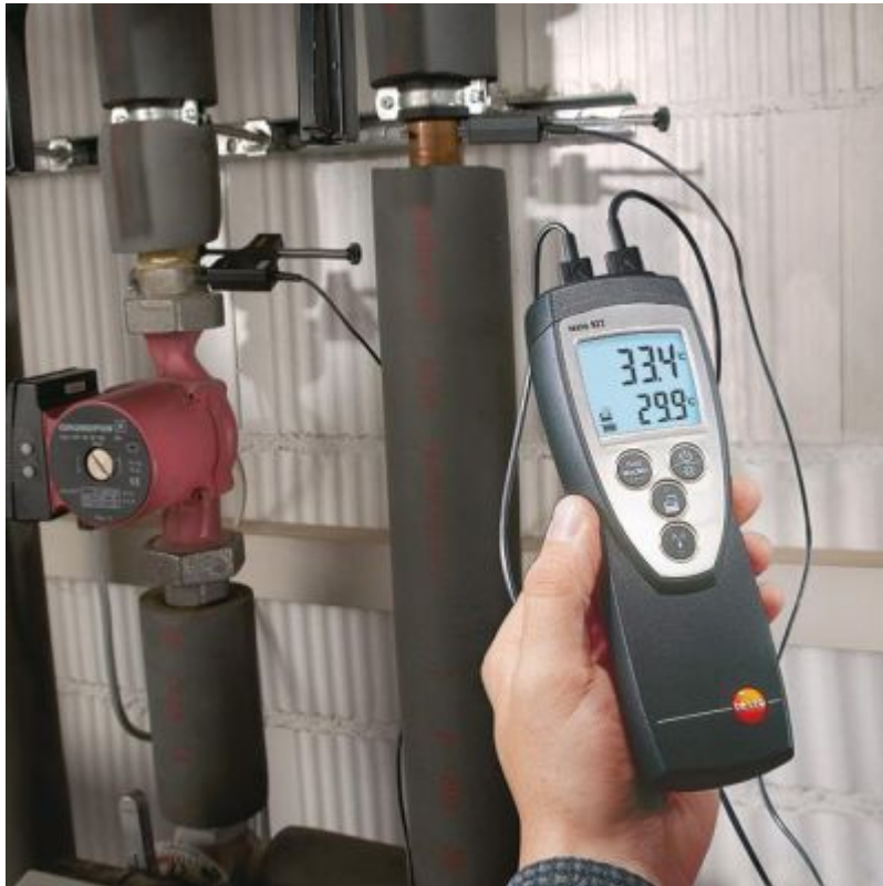
Differenz-Temperatur-Messung an einer Heizungsanlage
