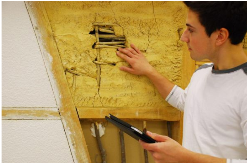
Neue Karrierechance im Handwerk: Ausbau Bachelor (cra)
