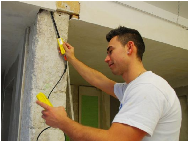
Neue Karrierechance im Handwerk: Ausbau Bachelor (cra)
