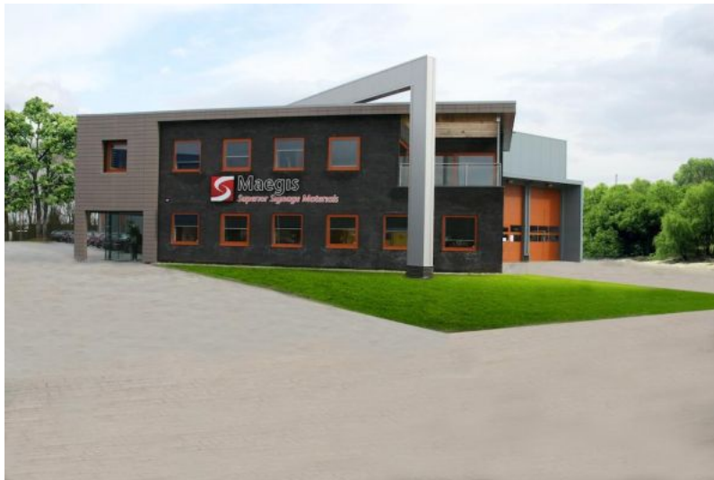
Tecco verstärkt Aktivitäten in BeNeLux: Maegis Compleo Geschäftsgebäude in Enschede, Niederlande.
