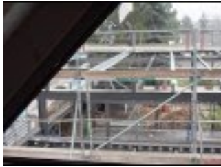
Bau der Museumserweiterung Stand 4. Dezember 2014
