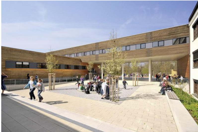
Modulgebäude Gymnasium Landesberg am Lech
