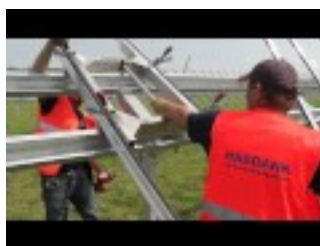
Habdank PV, Solarpark Ammerland Wiefelstede/Oldenburg
