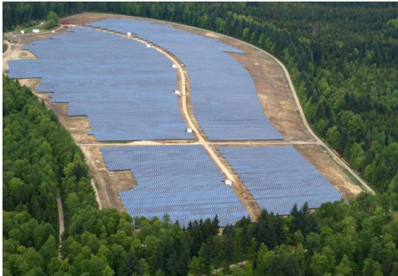
Energieversorger EnBW, 10 MW Kraftwerk Königsbrunn-Ochsenberg
