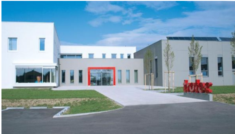
Das zertifizierte GreenBuilding von Trotec in Österreich
