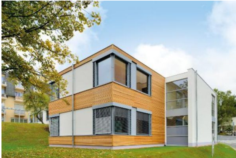
motivierendes Lernumfeld mit ALHO Modulbauweise
