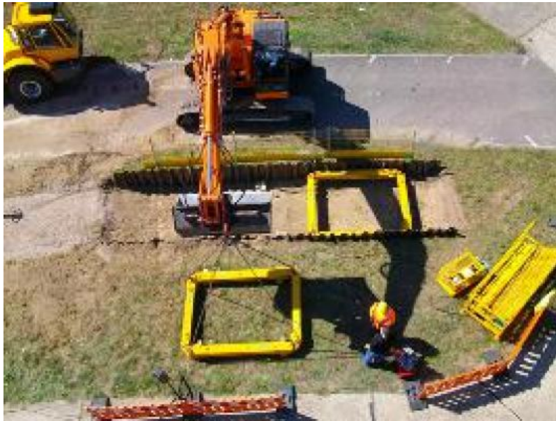
einfacher und sehr schneller Einbau des hydraulischen Gurtungsrahmens ohne Schweißarbeiten
