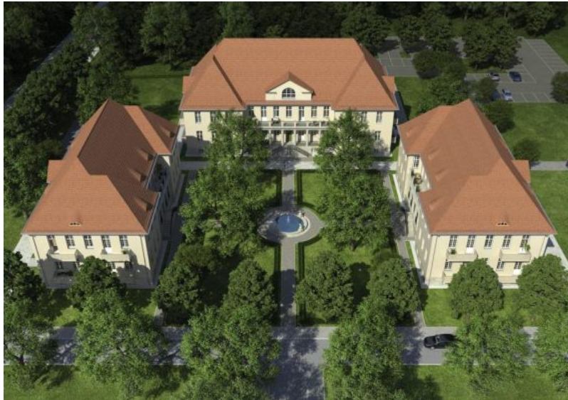
Die drei Villen der Landhausgruppe in Berlin-Buch werden aufwändig saniert.
