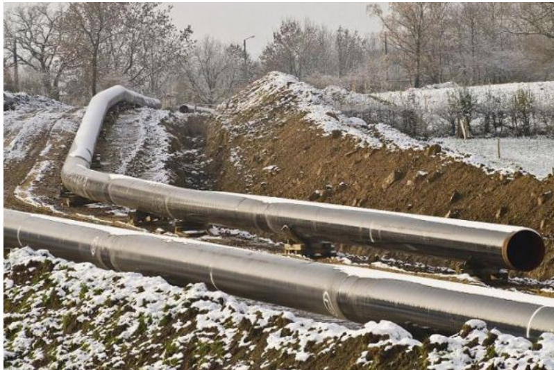
Das Bild zeigt den aktuellen Bau der Rohrpost-Teststrecke
