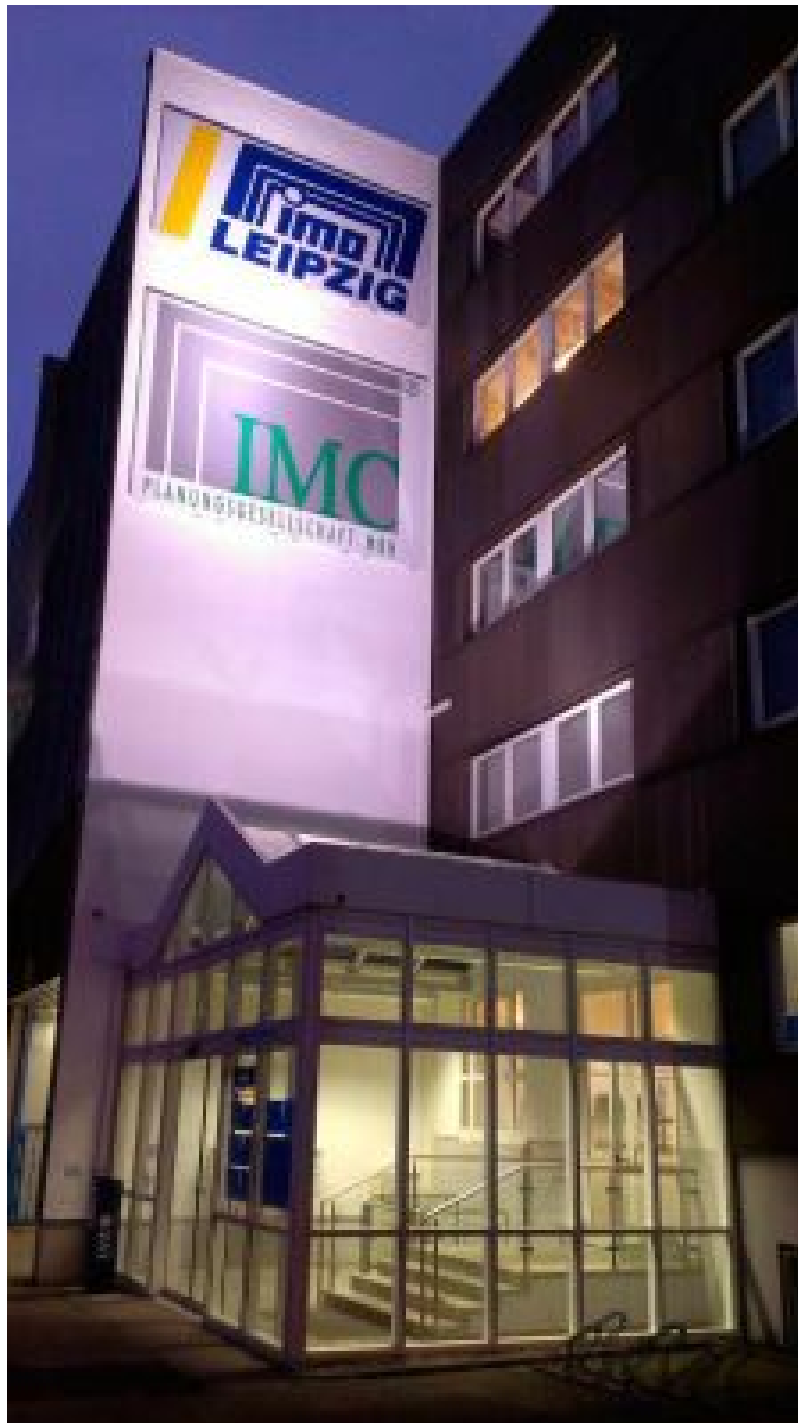
Neue Fassadengestaltung Bürogebäude Leipzig
