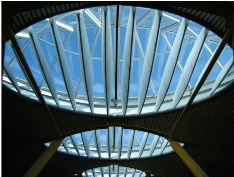
Die Glas-Silicon-Membran BATYLINE SK 300 von Ferrari
