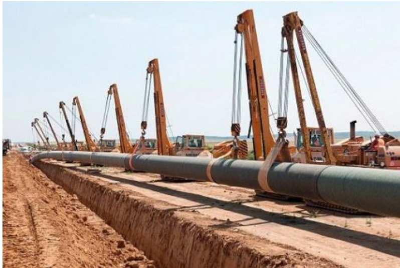
Neun Seitenbaumraupen senken die Pipeline in den Rohrgraben ab.
