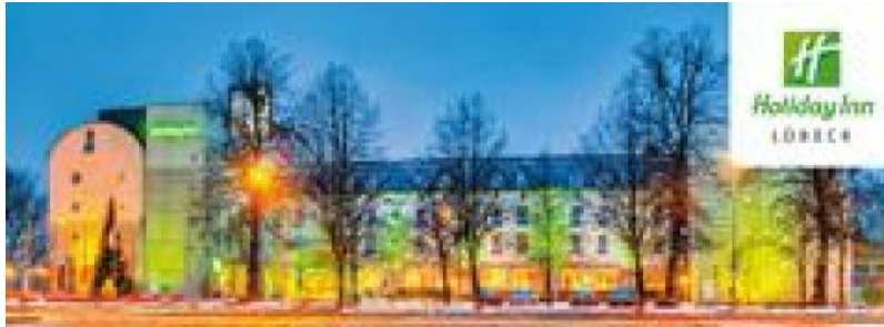
Das Holiday Inn Lübeck befindet sich in zentraler Lage am Burgtor
