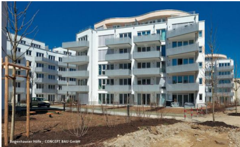
Bogenhauser Höfe (c) Concept Bau GmbH
