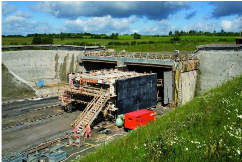
Bereit zum Einfahren in den Tunnel. Das Betonieren begann am bergmännischen Ende des Tunnels.
