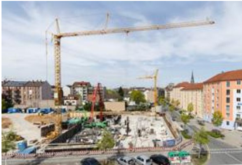
Belebte Baustelle: Die Bauarbeiten an den Herrnhöfen schreiten voran. (Bild: PROJECT Immobilien)
