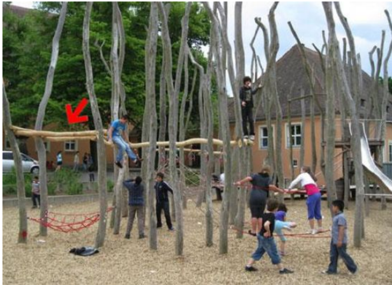
Nachträglich installierte Querverstrebungen in 3 Meter Höhe, Foto: Bechert
