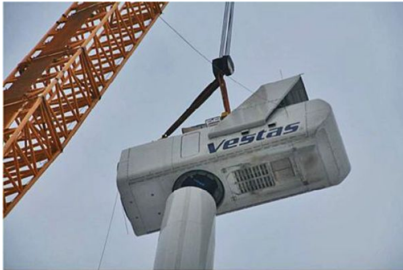
reconcept GmbH - Montage Maschinenhaus einer Windkraftanlage
