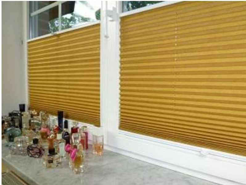
Montierte Plissee in Berliner Büro
