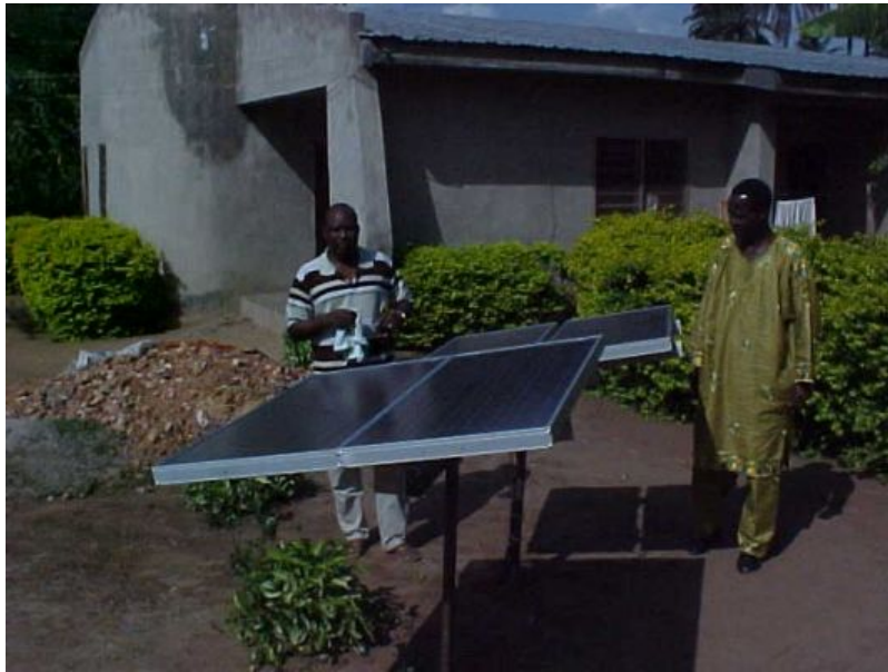
Der Aufbau der International Energy Academy geht voran
