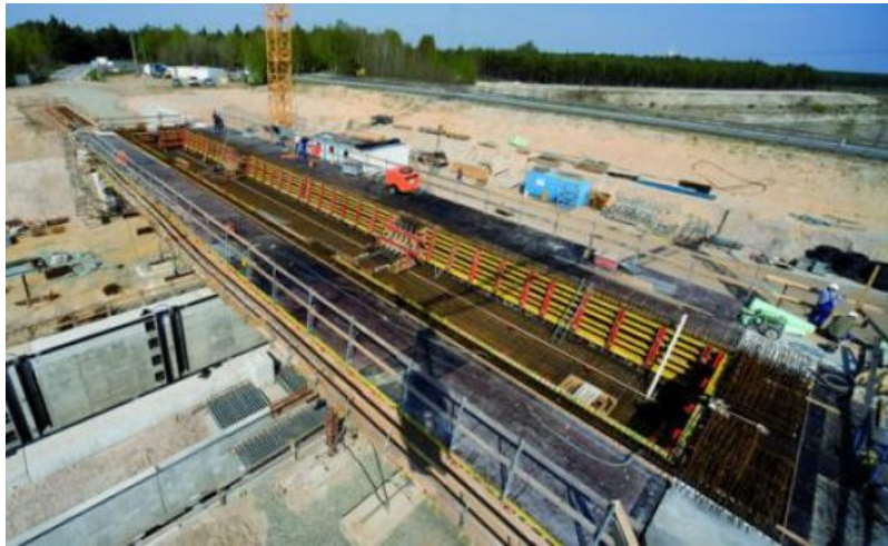
Über 95% standardisierte Schalelemente für die Schalung des Hohlkastens.
