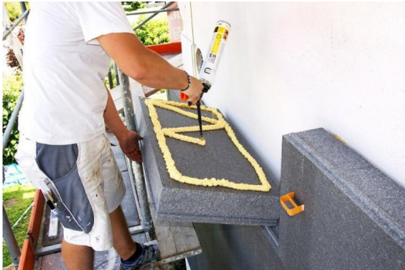
Im Sommer kühlt eine Fassadendämmung vom Stuckateur-Meisterbetrieb
