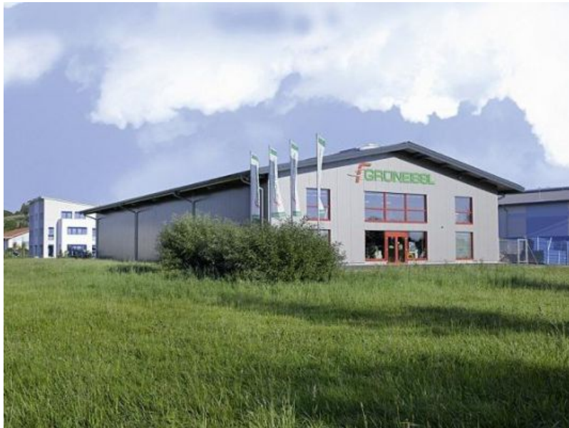
Losberger Stahl-Systemhalle, 22 x 42 m, isoliert, Verkaufsraum mit angrenzendem Lager
