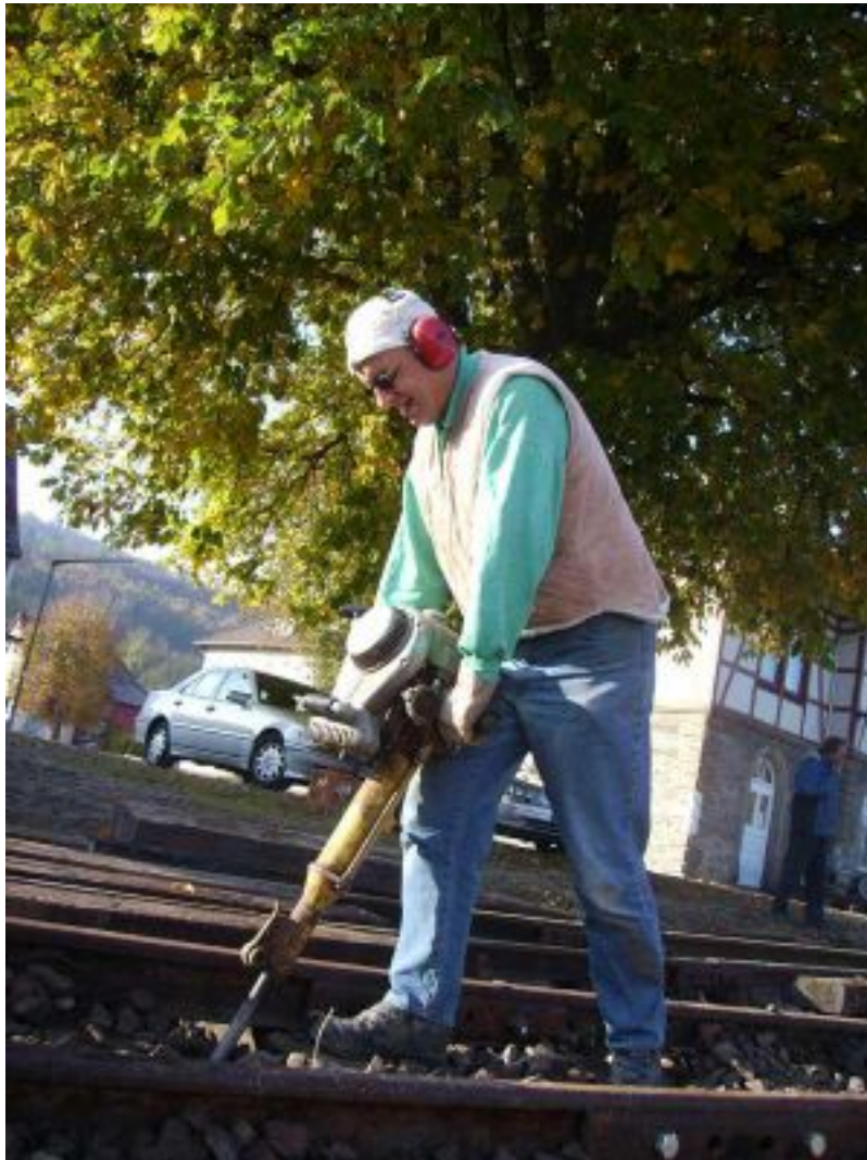
Gleisbauarbeiten (Foto: Trends, frei zur Veröffentlichung bei Namensnennung)
