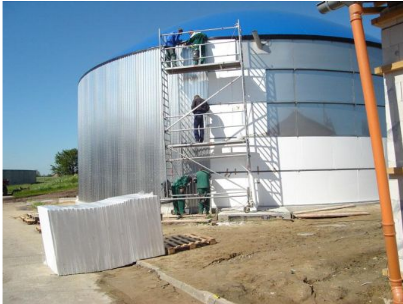
Biogasanlage von WELTEC BIOPOWER im Bau
