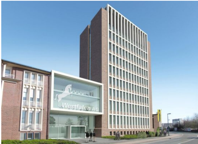
Der neue elfgeschossige Büroturm (rechts) stellt Bezüge zum Altbau (links) her.
