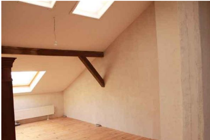
Dachgeschoss saniert mit epatherm
